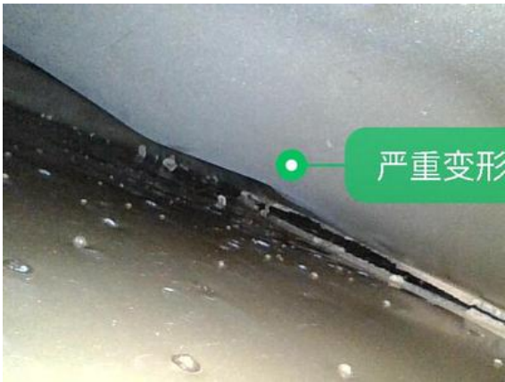
右后翼子板内骨架:严重变形
