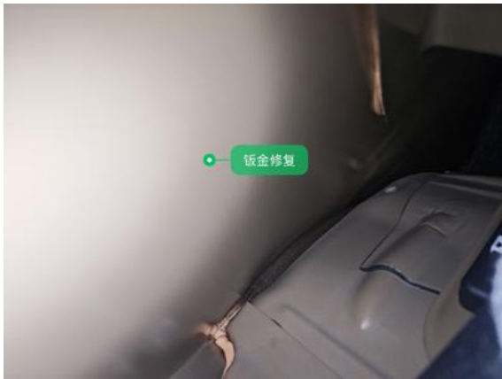
左后翼子板:钣金修复
